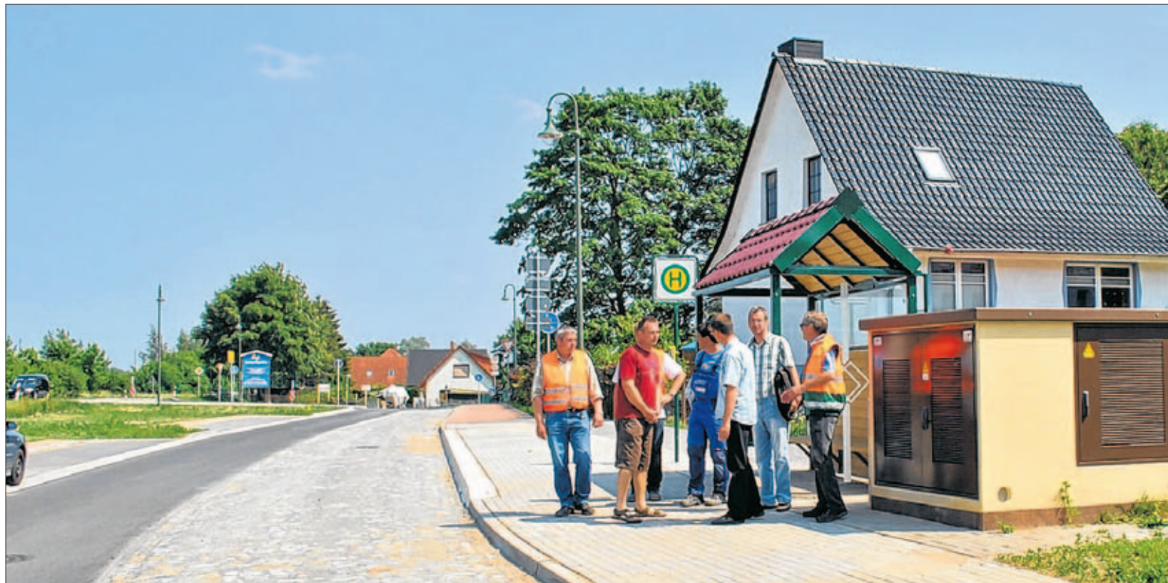
Bis auf die Bepflanzung ist die Umgestaltung des Parkplatzes mit Haltestelle, Bänken und Karte der Gemeinde abgeschlossen.
