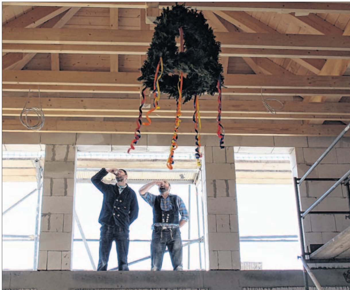
Gestern bekam das Dorfgemeinschaftshaus die Richtkrone aufgesetzt.
