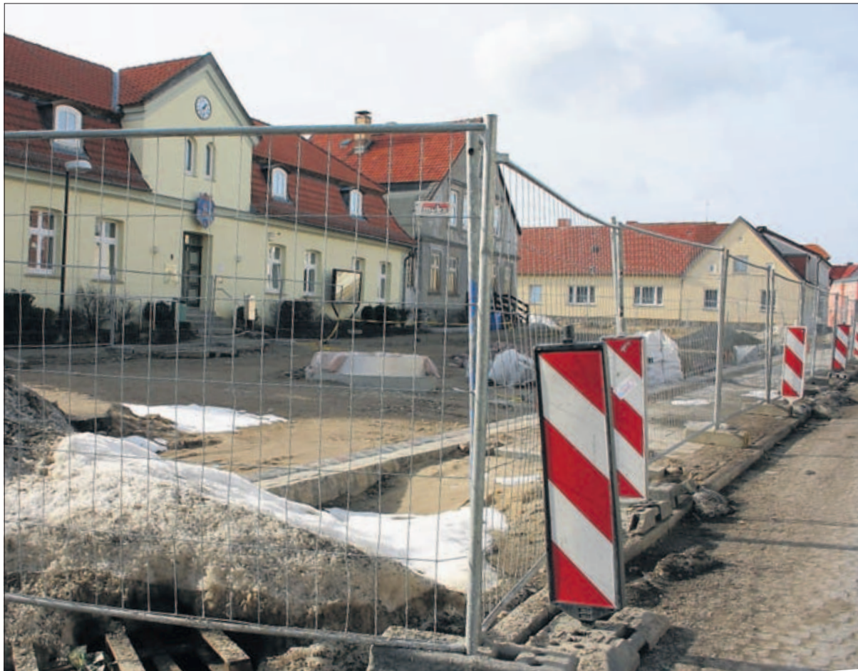
Nächste Woche rücken auf dem Franzburger Markt wieder die Bauleute an. Der Platz erhält neues Pflaster. Foto: C. B.
