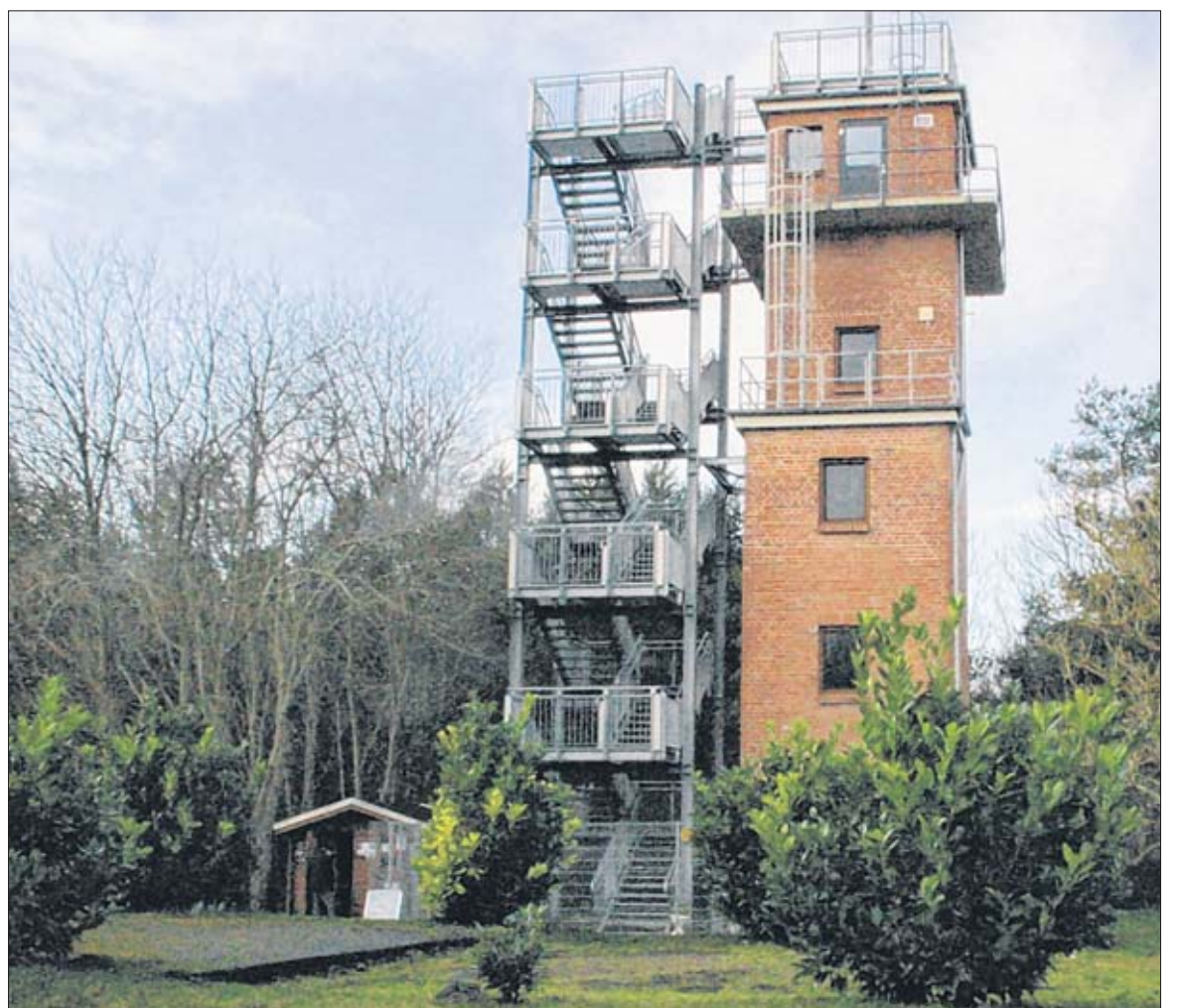
Neben dem Turm wird das „Haus am Turm“ gebaut, sozusagen als umgekippter Zwillingstürmchen. Foto: I. E.
